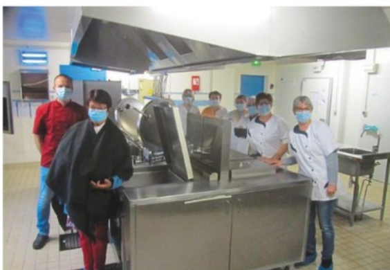
Les nouveaux équipements de la cuisine assurent les repas de la résidence mais aussi du portage à domicile et de la cantine scolaire.
